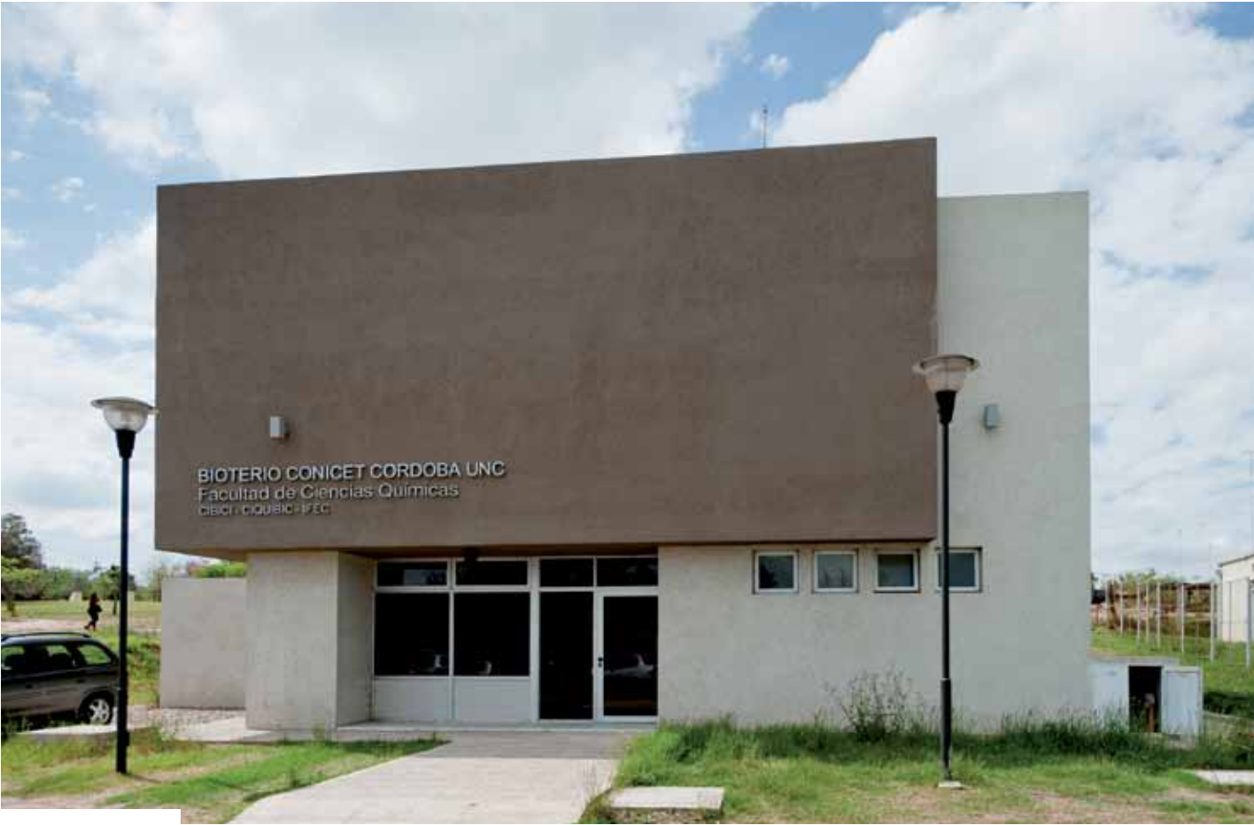
La convocatoria del PFI, que cuenta con tres etapas, permitió la construcción de edificios tales como el Centro de Investigaciones en Bioquímica Clínica e Inmunología de Córdoba (CIBICI-CONICET).
