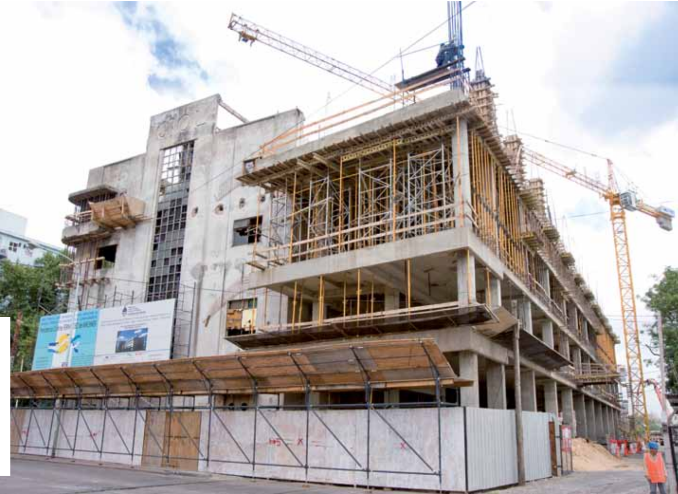
El proyecto de obra procuró preservar la fachada del antiguo edificio de las Bodegas Giol, y así recuperar un espacio cargado de valor social cultural para el barrio.
